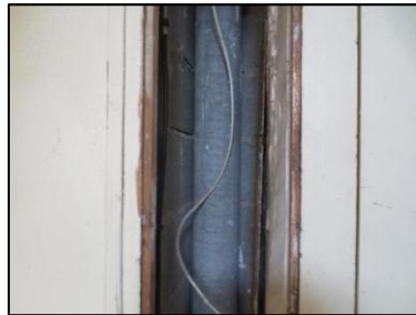
Photo N° 1071 AMIANTE CIMENT -- PLACARDS TECHNIQUES -1 à +3 Conduits de fluide Chute E.P.(Fibres- ciment)
